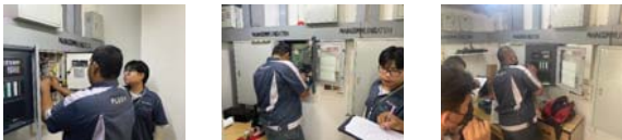
การตรวจสอบระบบป้องกันและเตือนอัคคีภัย
